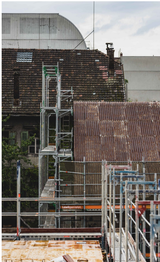
Ein letzter freier Blick auf das Chäs- und das Eisenlager.
