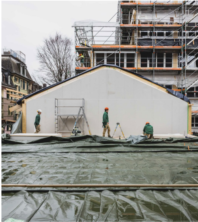
Aufstockung in Sicht – das ehemalige Eisenlager wird zweistöckig.
